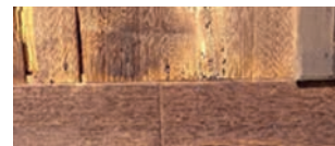
Detalle del cerramiento exterior en piezas de madera imitando un trazado de aparejo trabado.
