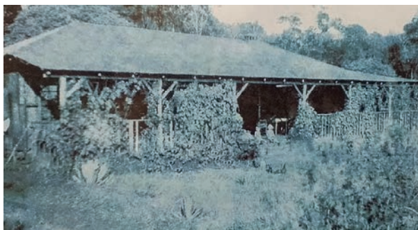
Imagen 3. Vivienda de la familia Roth en el año 1927. Primera etapa constructiva de la vivienda Definitiva. Estructura de madera independiente. Fuente: Museo familia Roth.
